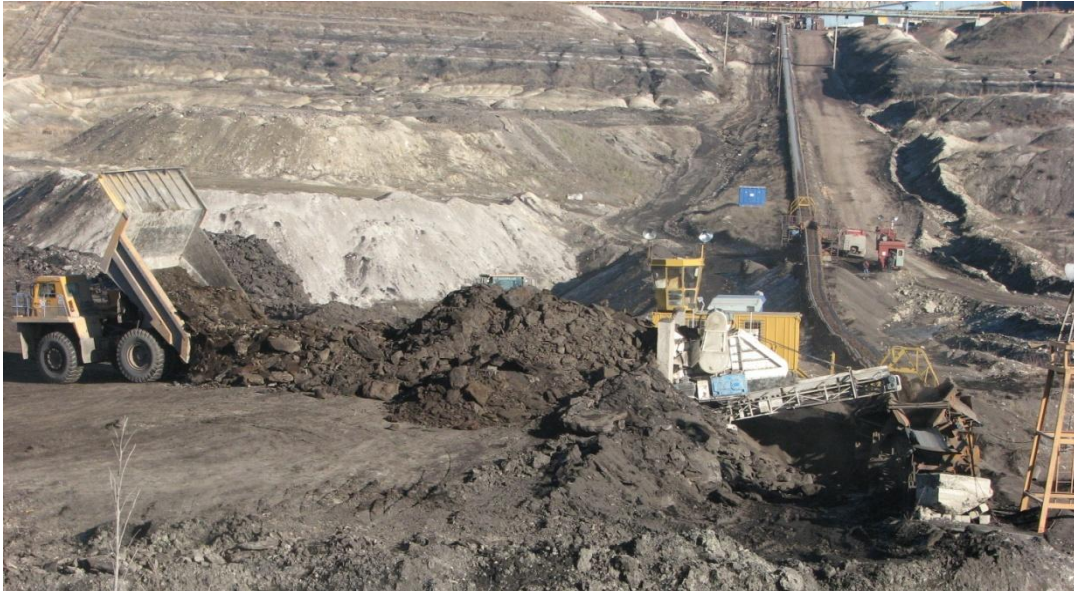
Slika 1. Drobilično postrojenje SB 1315 u radu
