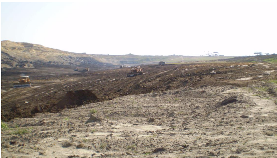
Slika br.1 - Uređenje podloge deponije pepela i šljake
