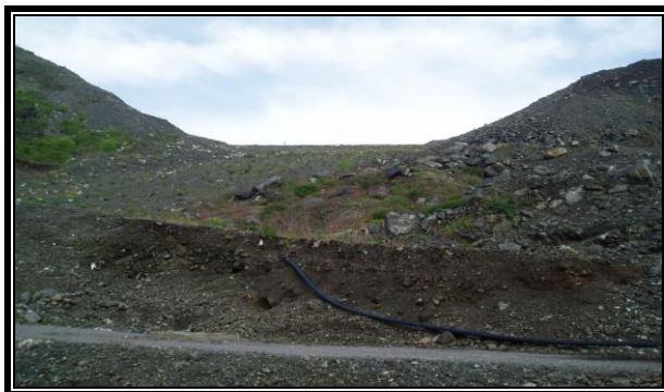
Slika 10 – Brana izgrađena na dnu sanirane deponije „Vujan“ u Gornjem Milanovcu (foto: M. Rakijaš, 2008)
