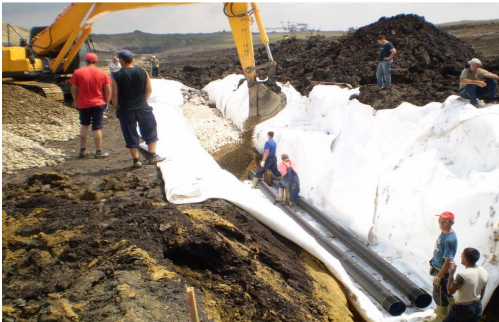
Slika br.2 - Izrada drenažnog tepiha
