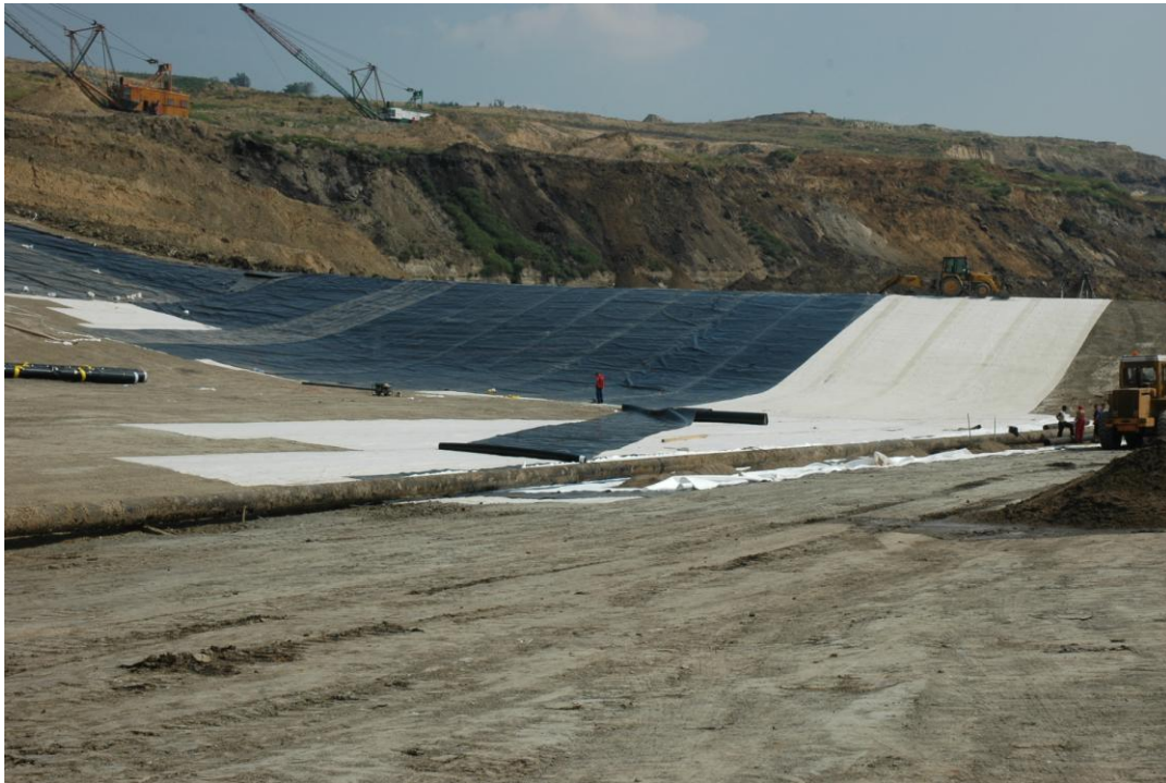
Slika br.5 – Postavljanje bentonit folije i HDPE geomembrane
